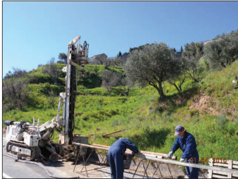
FOTO 1: Macchia operatrice posizionata sul sondaggio S 1
